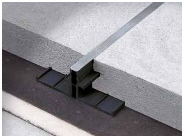
Für die Mörtelverlegung geeignete Verbindung aus doppeldichtem synthetischem Material. Sie besteht aus zwei starren Strukturteilen, die durch weiche, Kunststoffbeschichtete Einsätze verbunden sind, die in verschiedenen Farben erhältlich sind. Die CMB-Verbindung wird verwendet, um den Unterboden oder Estrich je nach Projektanforderungen zu teilen.
